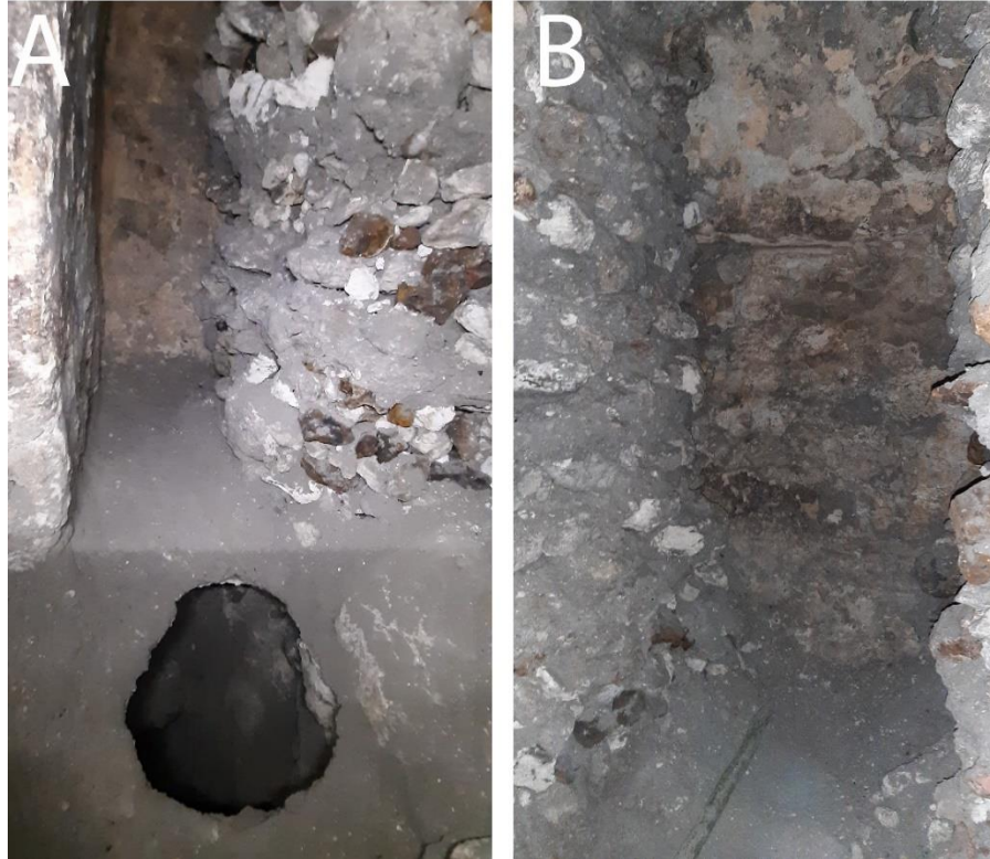
Figura 3.12. A) Registro 1 hacia el oeste, B) Muro norte del cuarto 7 (Foto César Enríquez).
