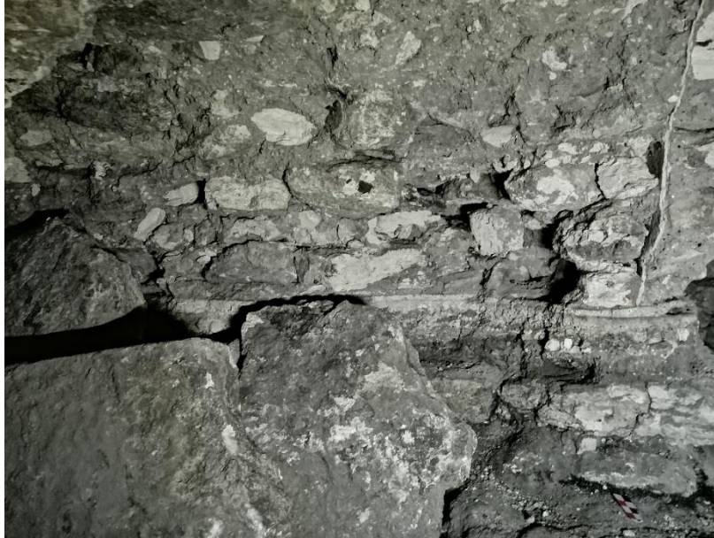
Figura 4.19. Relleno de la estructura, nótese la presencia del piso estucado (Foto de Melvin Dávila).
