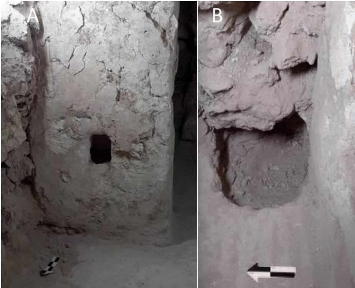
Figura 2.16. Sondeo de la huella de poste HOL.T.108.29 de la esquina inferior este de la fachada norte del muro HOL.T.108.33 (Foto: Berenice García Vázquez).
