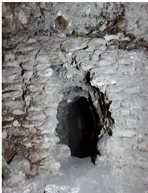
Figura 3.24. Registro realizado en el muro de contención al norte del cuarto 8 (Foto César Enríquez).
