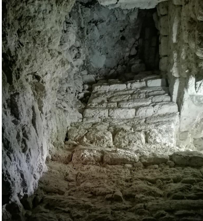
Figura 4.27. Bóveda con molduras o cornisas (Foto de Melvin Dávila).
