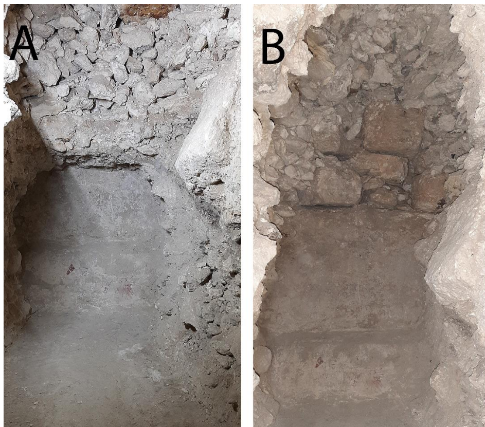
Figura 3.10. A) Muro norte al final del pasillo (CHO.T.11.34), B) Muro norte y tapiado con bloques de caliza (Foto César Enríquez).
