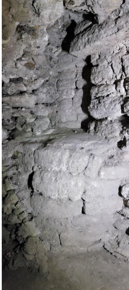
Figura 1.10. Vista de la esquina suroeste de la subestructura que comprende los cuartos T.11.36 y T.11.81. Se puede observar que la subestructura T.11.81 y su esquina redondeada están adosadas al muro y cornisa del friso de la subestructura T.11.36 (Foto de F. Estrada-Belli).
