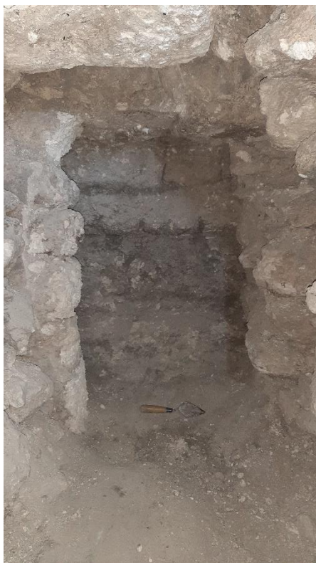
Figura 3.43. Muro CHO.L.12.81 (Foto César Enríquez).
