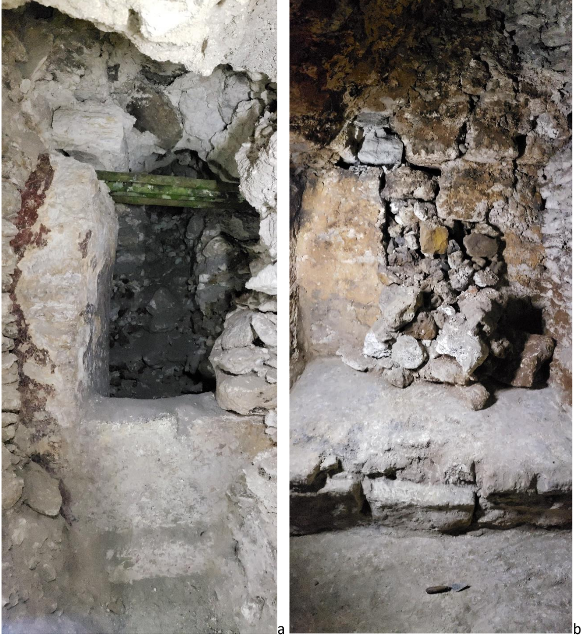
Figura 1.8. a) Umbral parcialmente bloqueado por un muro con moldura basal estucada (T.11.47) de 1 metro de alto entre los cuartos T.11.36 y T.11.81 de la Estructura Central del Grupo Norte. Se colocaron palos verdes en lugar del dintel del vano para prevenir colapso del muro superior, y b) banqueta T.11.55 y puerta rellena en la pared oeste del cuarto T.11.81 (Fotos de F. Estrada-Belli).
