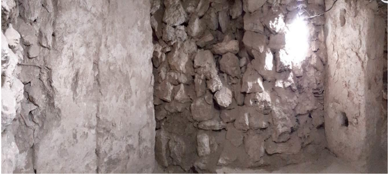
Figura 2.14. Vista en 180° del interior del recinto, el extremo izquierdo el muro HOL.T.108.35, al centro parte del relleno HOL.T.108.34 y al extremo derecho la fachada norte del muro HOL.T.108.33 (Foto: Berenice García Vázquez).
