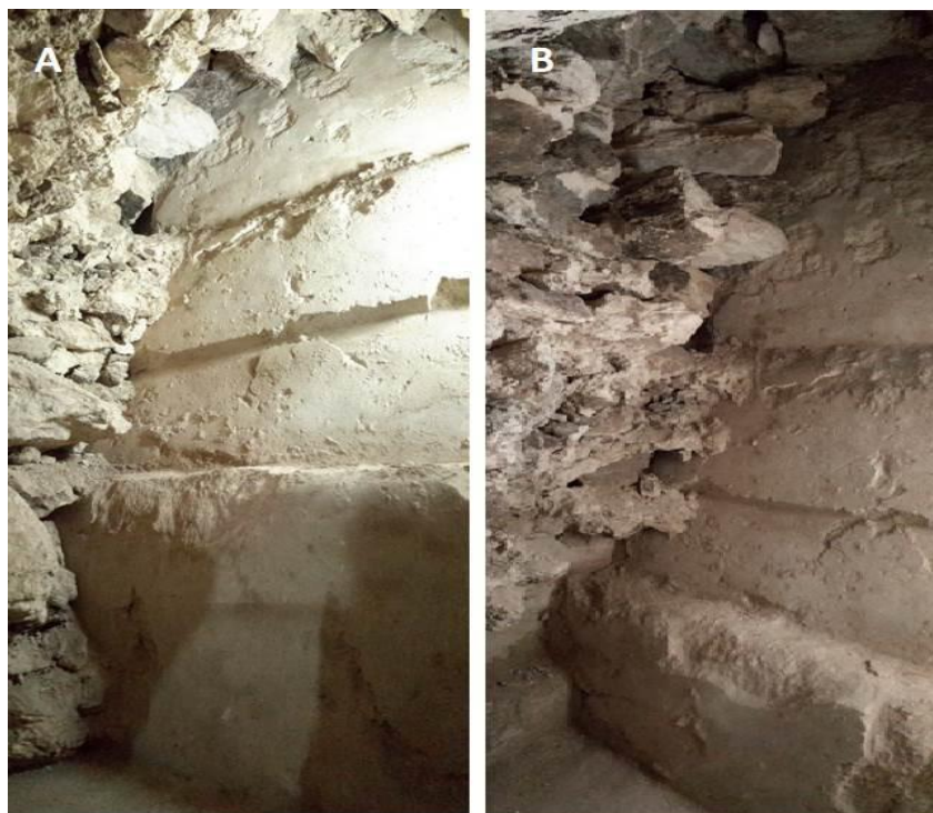
Figura 2.1. A) Comienzo de la excavación al oeste del talud de la plataforma HOL.T.108.13; B) Localización del talud basal HOL.T.108.17 al extremo inferior, esquina oeste (Foto: Berenice García Vázquez).
